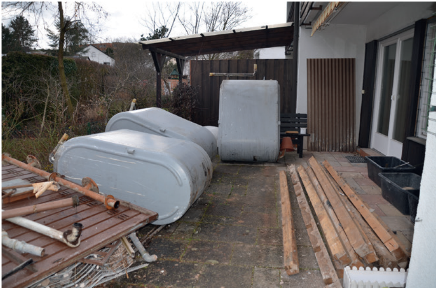
Abb. 5 Zwischenlagerung der Öltanks und anderer Entkernungsmaterialien auf der Terrasse
