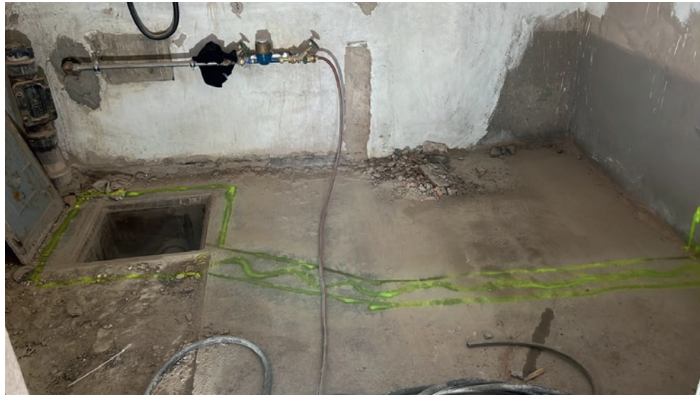
Abb. 3 Der ehemalige Heizungskeller nach Herausnahme der Ölheizung mit einem Brenner direkt über dem Entwässerungsschacht und der durch eine (beseitigte) Mauer und Schutzanstrich als Auffangwanne gesicherten 3 × 1.000 l-Öltanks
