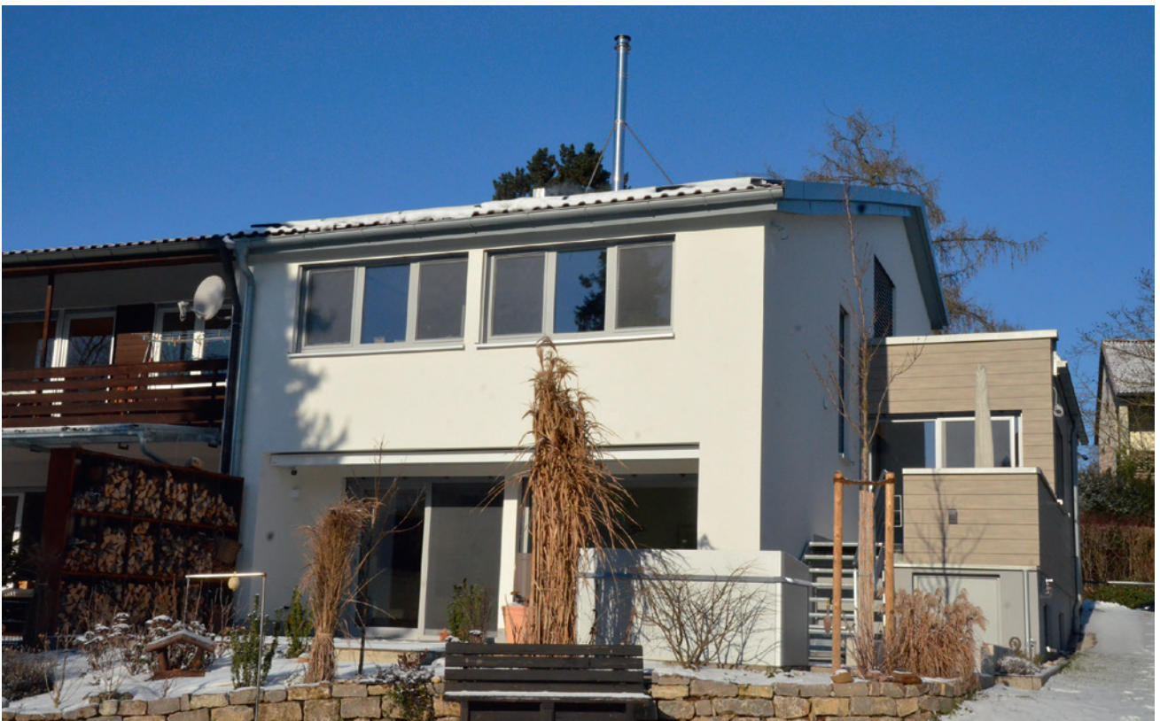
Abb. 1a+b Die Doppelhaushälfte vor und nach der Sanierung
