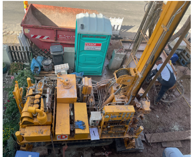
Abb. 3+4 Das Bohrergerät im Vorgarten aus dem Bad heraus fotografiert; die beengten Platzverhältnisse erforderten die Sperrung des öffentlichen Gehweges sowie eine verkehrsrechtliche Genehmigung mit angeordneter Beschilderung (oben). Nach Erreichen der Endteufe wurde an das mit Wasser gefüllte Erdwärmesondenbündel ein Gewicht gehängt und der Einbau von der Haspel konnte beginnen (unten).
