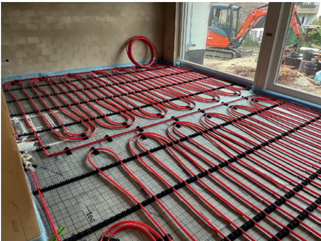
Abb. 2 Die Fußbodenheizung besteht aus einem patentierten Ovalrohrsystem, welches mittels Clips einfach installiert wird.
