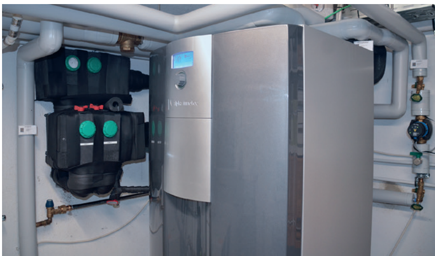
Abb. 7 Die Hauseinführung der Erdwärmesonden erfolgte direkt zur Wärmepumpe im Heizungskeller.
