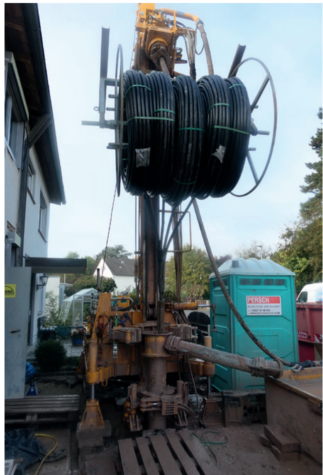
Abb. 3+4 Das Bohrergerät im Vorgarten aus dem Bad heraus fotografiert; die beengten Platzverhältnisse erforderten die Sperrung des öffentlichen Gehweges sowie eine verkehrsrechtliche Genehmigung mit angeordneter Beschilderung (oben). Nach Erreichen der Endteufe wurde an das mit Wasser gefüllte Erdwärmesondenbündel ein Gewicht gehängt und der Einbau von der Haspel konnte beginnen (unten).
