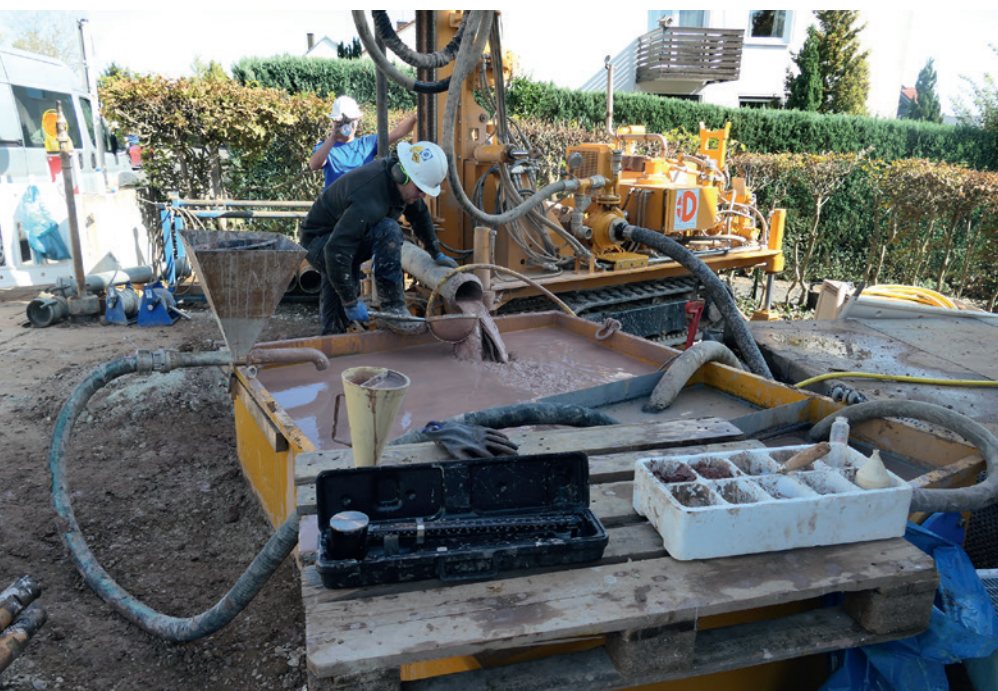
Abb. 6 Während der Bohrarbeiten wurde regelmäßig die Spülung kontrolliert und es erfolgten Probenentnahmen des Bohrguts durch ein Sieb aus dem Spülungsstrom.
